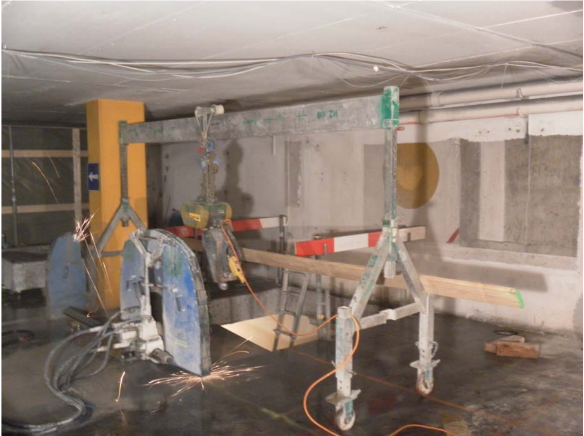
Illustrer: Ein weiterer Deckendurchbruch entsteht
