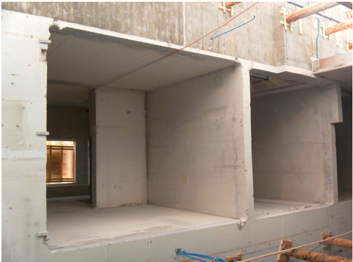
Illuster, die neuen Treppenhäuser und Liftschächte von unten
