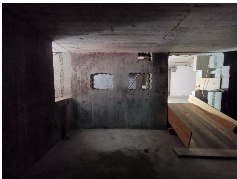
Fertig geschnittene Durchbrüche. Doppelwände mit Stärken von bis zu 70cm.
