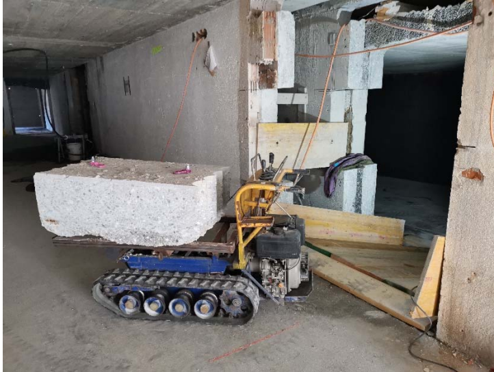
Zwischentransport der geschnittenen Einzelstücke zur Mulde mittels selbst konstruiertem Raupendumper.
