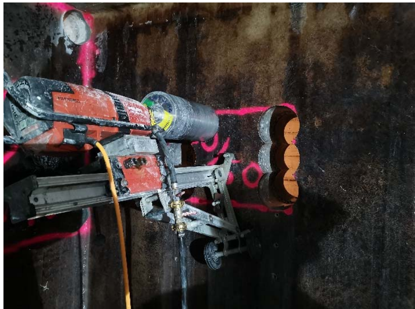
Diverse Kernbohrungen in allen Lagen und Grössen.
