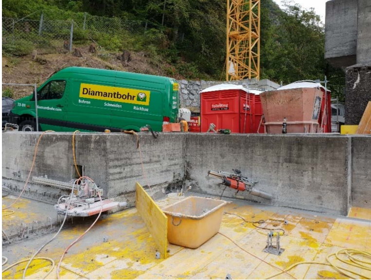
Rückbau Betonbrüstungen im 9.OG für neue Betondecke
