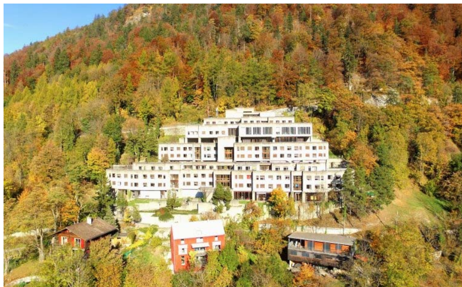
Konvikt Sichtbetonbau an Hanglage
