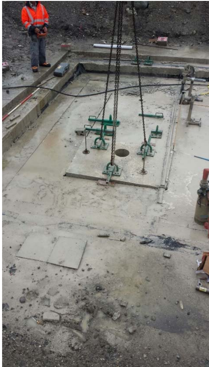
Befestigung zum Herausheben des ersten Blockes
