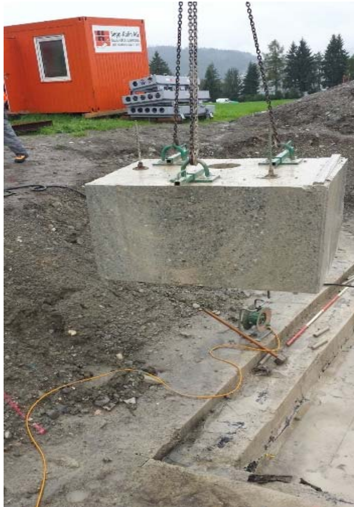
Gut befestigt wird Block für Block ausgehoben
