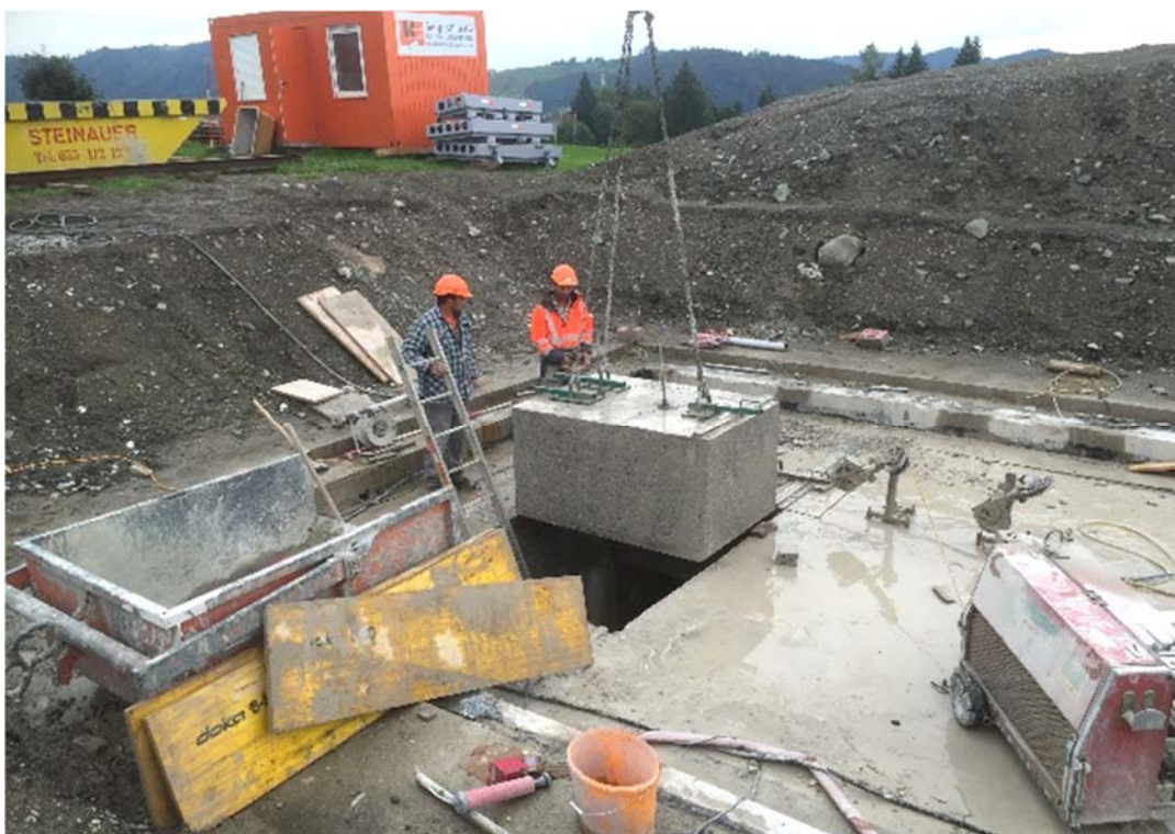
Ausheben des zweiten Blockes
