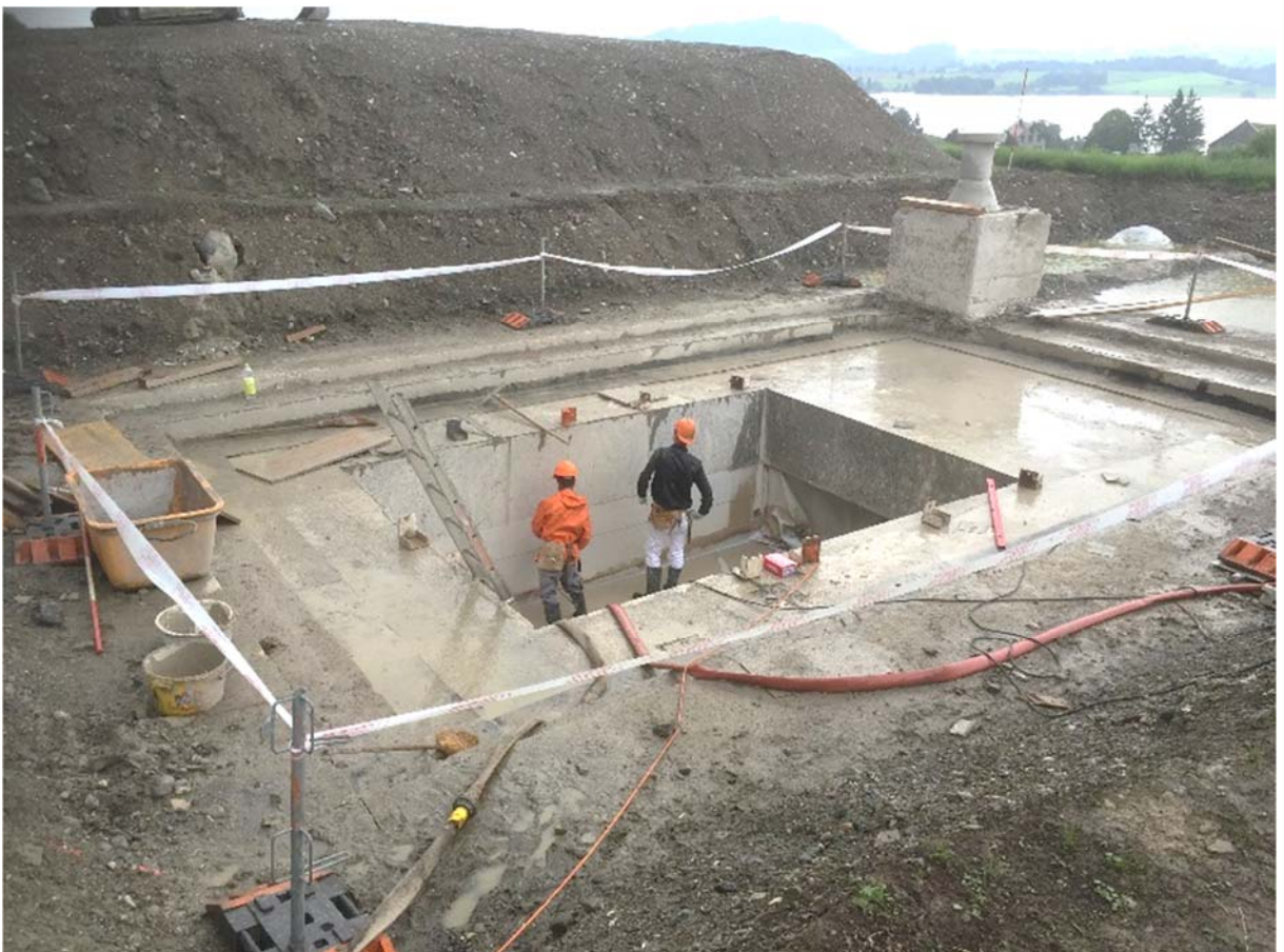
Blick auf die fertige Deckenöffnung
