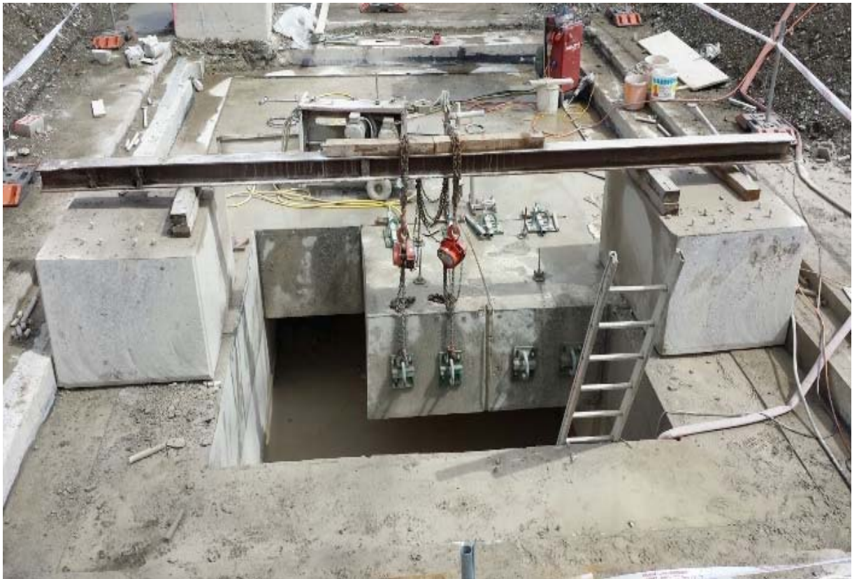
Sicherung der Blöcke
