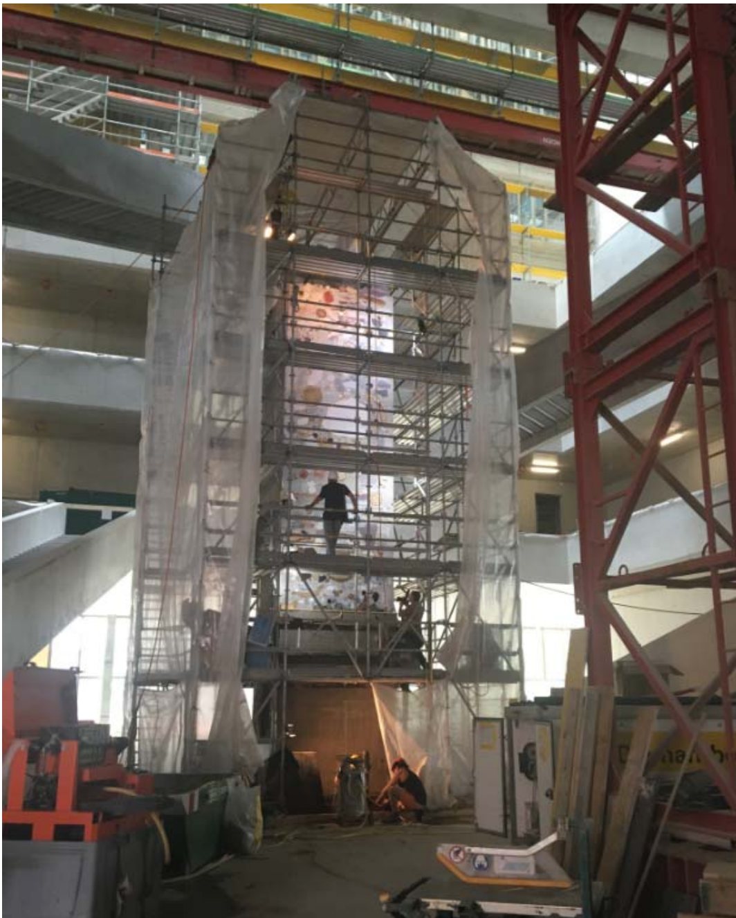
Stand der Arbeiten am 23. Juni 2017
