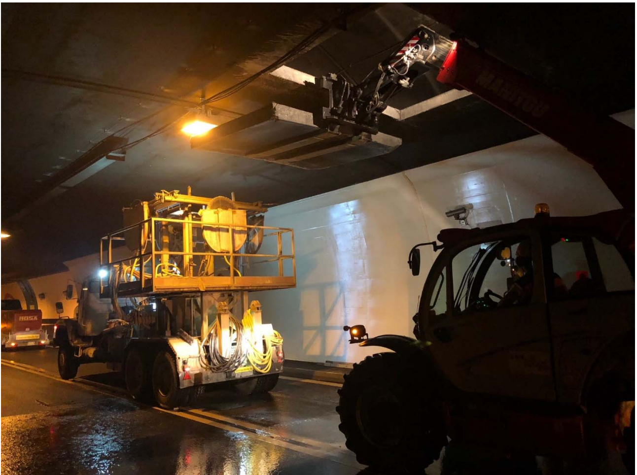
Ausbauen einer geschnittenen Brandklappe
