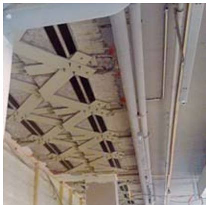
Kombinierte Verstärkung CFK- und Stahllamellen
