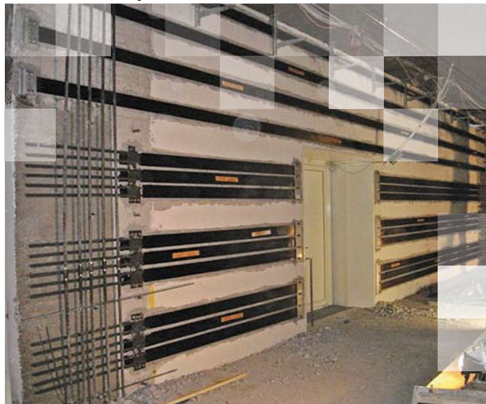
CFK-Lamellen mit Endverankerungen
