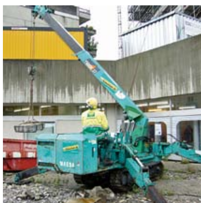
Thun: Rückbau von Balkonen, Absenken mit Maeda
