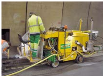
Gotthardtunnel: Schneidarbeiten mit Bodensäge, ausgerüstet mit Partikelfilter und Absaugeinrichtung
